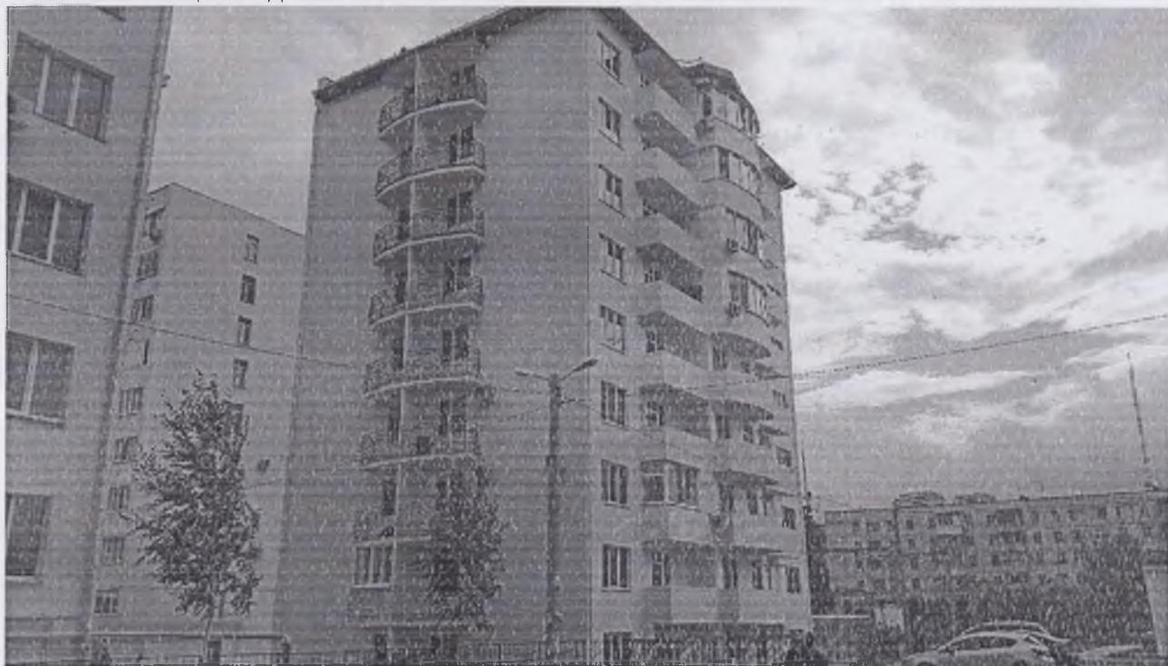
Фото № 1. Общий вид объекта.
